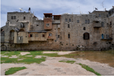
الواجهة الشرقية للبركة، منظر مأخوذ من الغرب
