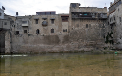
الواجهة الجنوبية للبركة، منظر من الشمال
